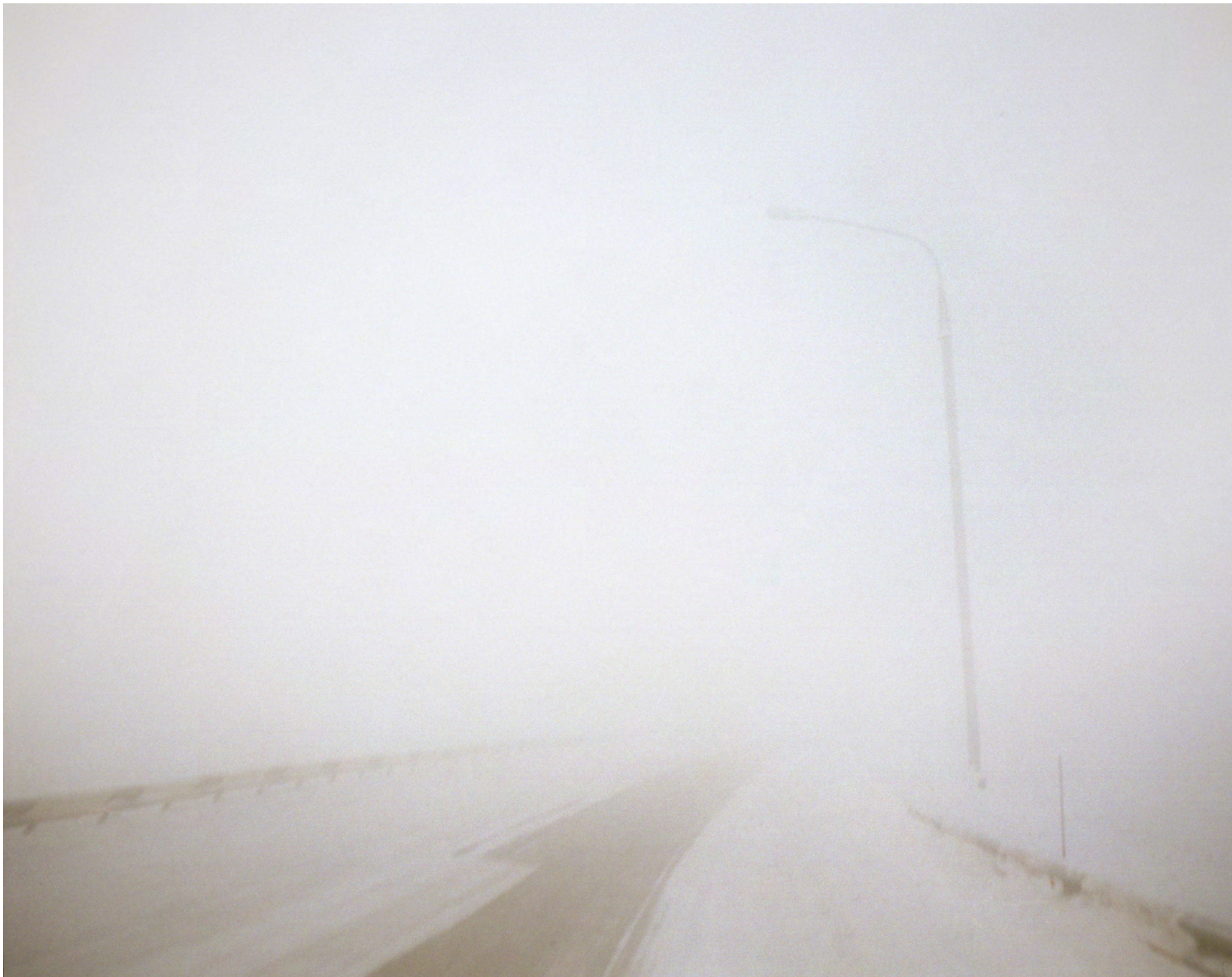
The Ring Road close to Vorkuta river. Obwodnica blisko rzeki Workuta.
